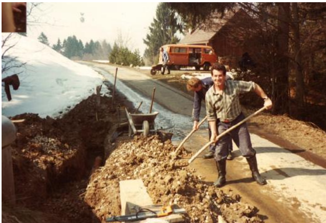
Schaufeln für die erneuerte Entleerungsleitung (Gusti Gisler, vorne; Emil Ottiger, dahinter)
