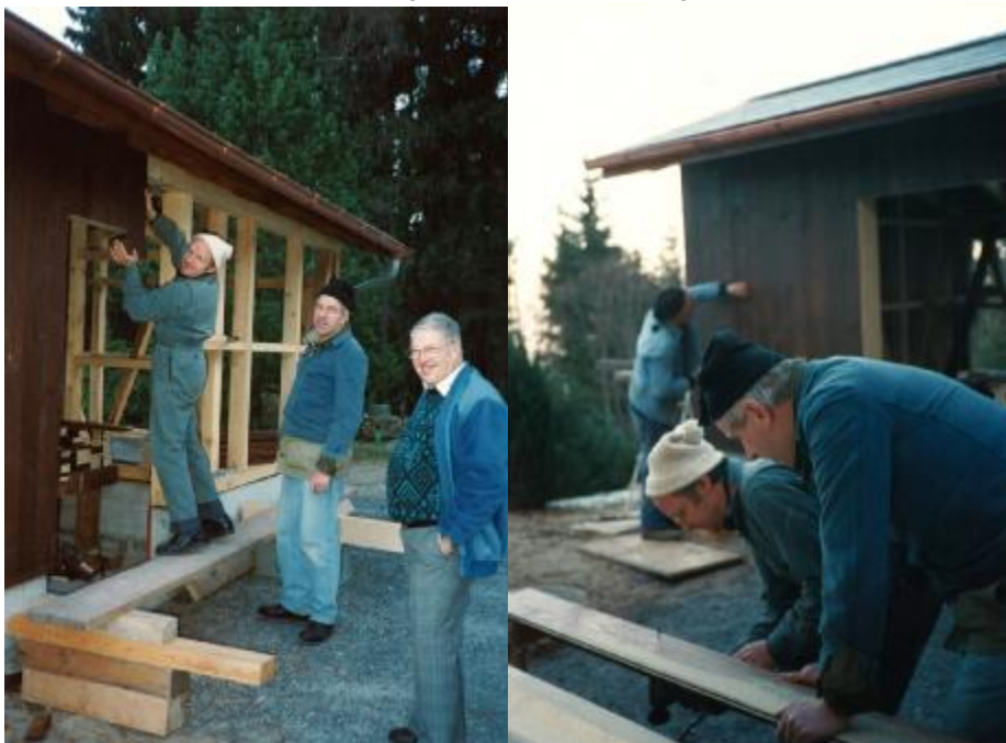
Anbringen der Aussenschalung
