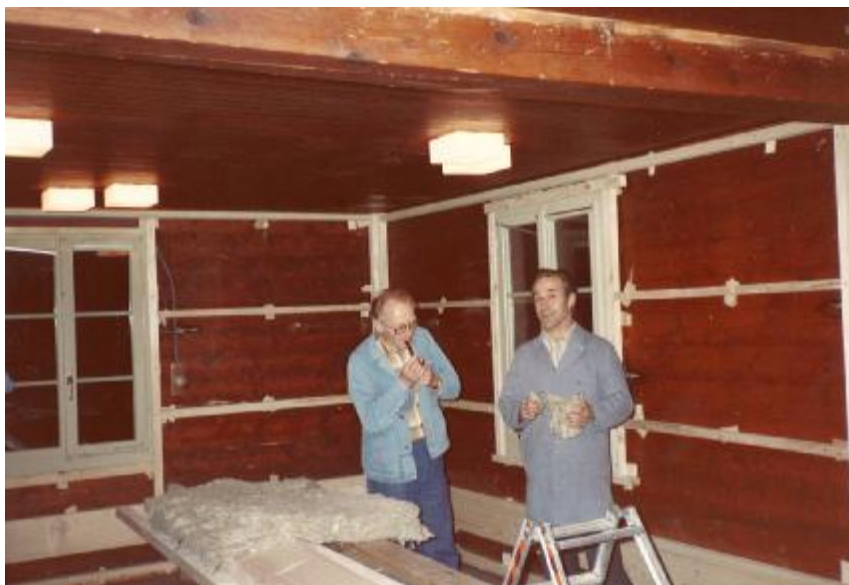
Der Elektriker und die Isoleure bei der Arbeit.
