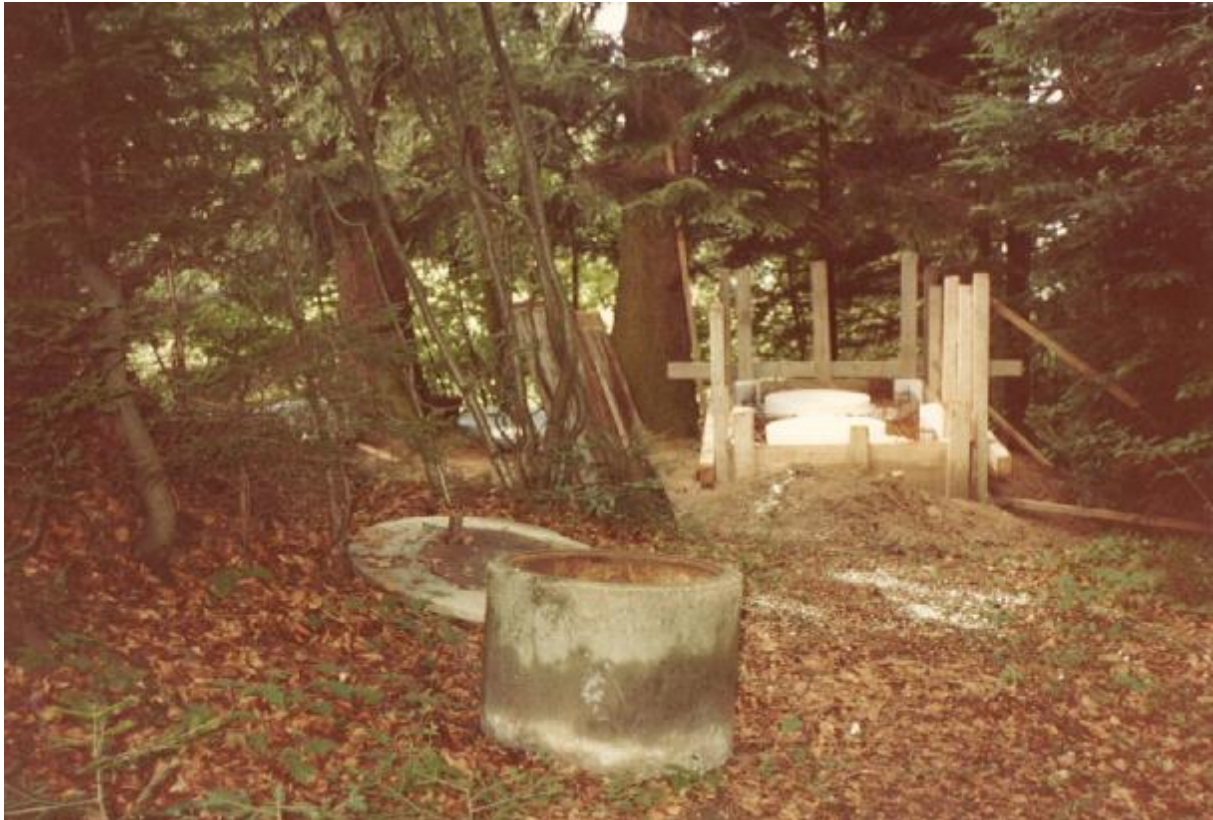
Die neue Abdeckung des Reservoirs bereit zum Betonieren. Im Vordergrund die alten Abdeckungen
