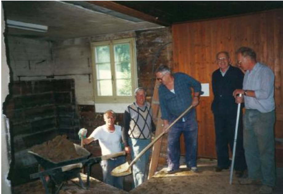
Aushub des Kellers für die Heizung in Fronarbeit
