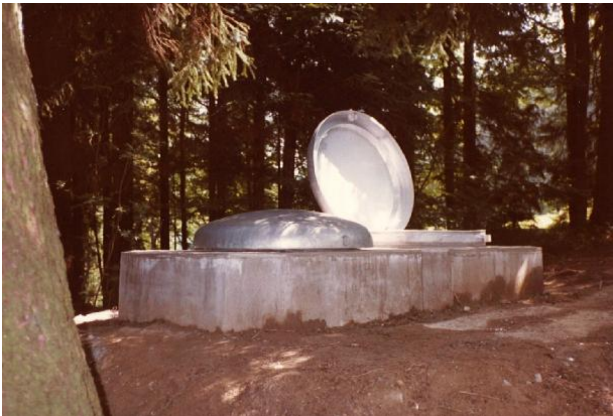
Die beiden neuen Brunnendeckel auf dem Betonsockel.
