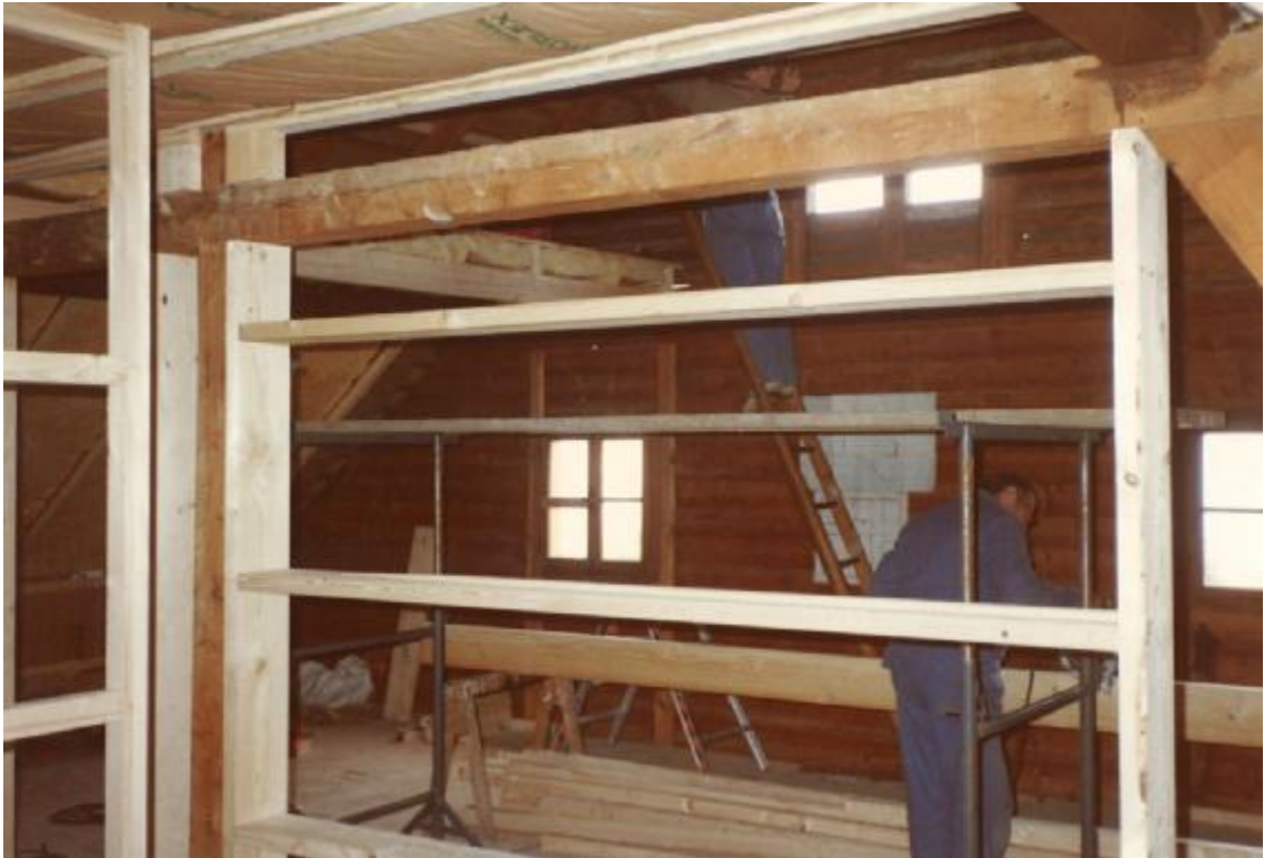
Umbau Schlafräume: Die Balken für die neue Raumeinteilung sind gesetzt.
