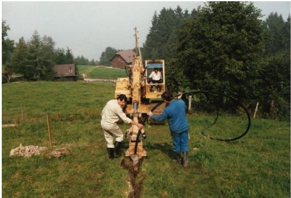
Verlegen der Kunststoff-Wasserleitung mit der Spezialmaschine.
