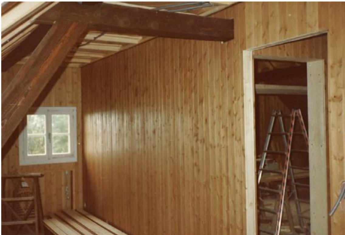
Umbau Schlafräume: Rohbau
