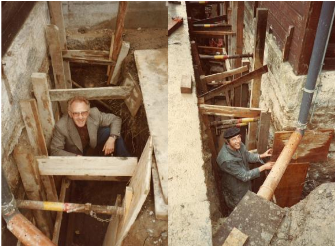
Baugrube für die Sanierung der bergseitigen Kellerwand.
