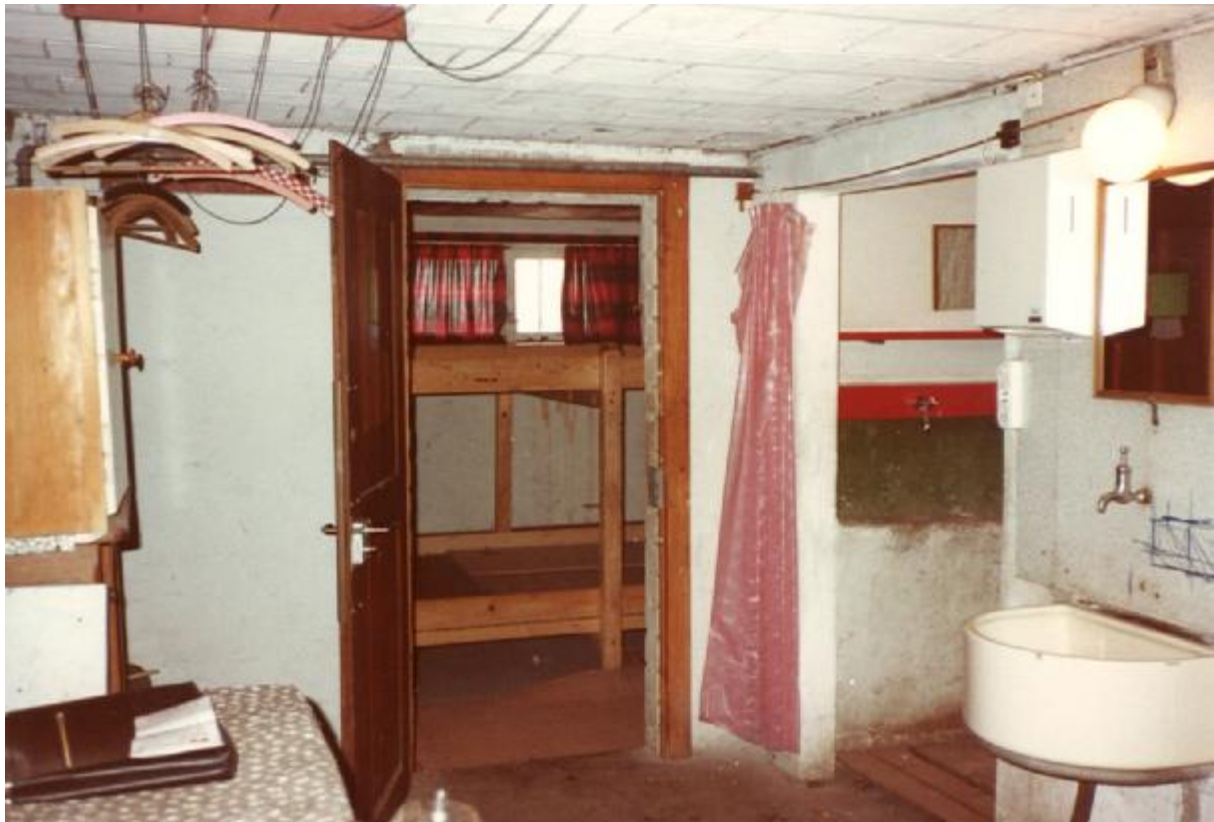
Vor der Sanierung: Blick in den Schlafraum
