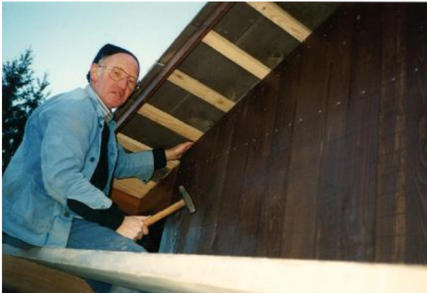
Anbringen der Aussenschalung
