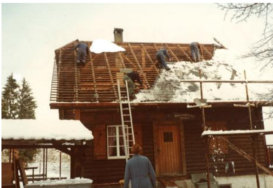
Dachsanierung: Abdecken des alten Daches in Fronarbeit.
